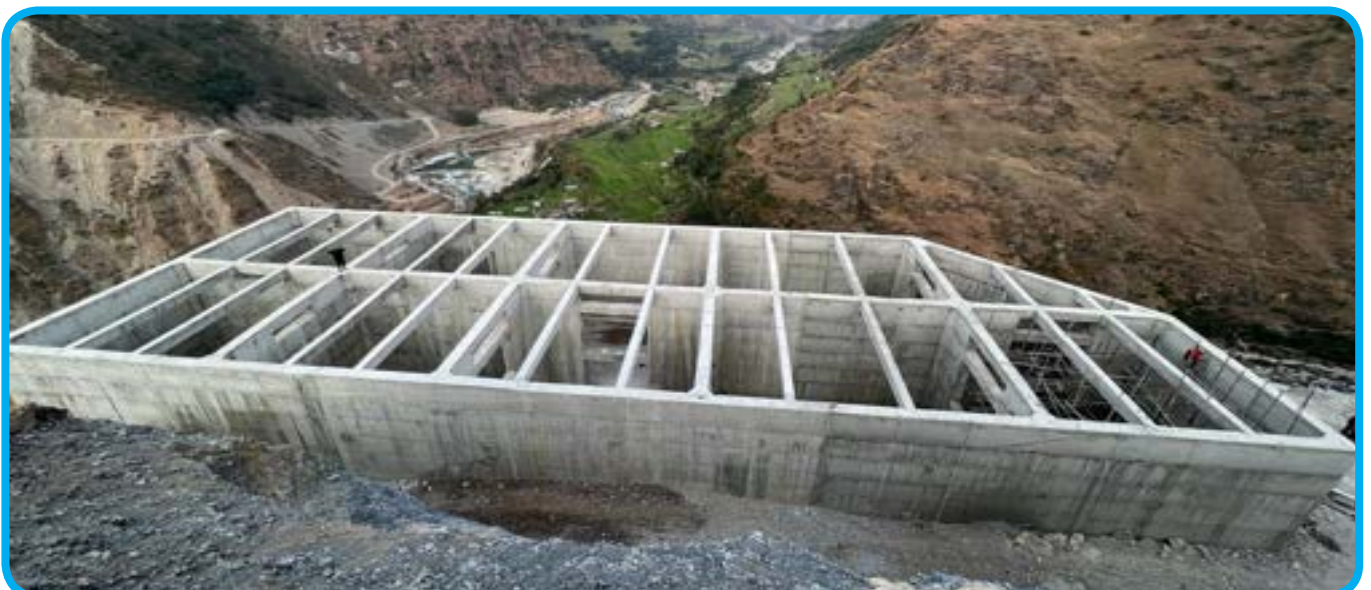
माथिल्लो चमेलिया जलविद्युत आयोजना (४०.० मेगावाट) को निर्माणाधीन सर्जट्याङ्क
