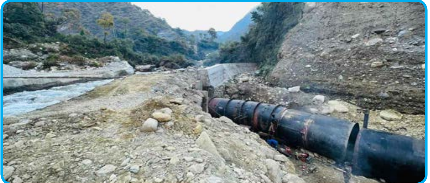
माथिल्लो चमेलिया जलविद्युत आयोजना (४०.० मेगावाट) को निर्माणाधीन अलाइनमेन्ट
