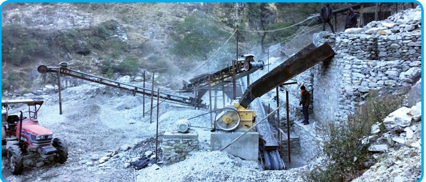
माथिल्लो चमेलिया जलविद्युत आयोजना (80.0 मेगावाट) को क्रसर प्लान्ट
