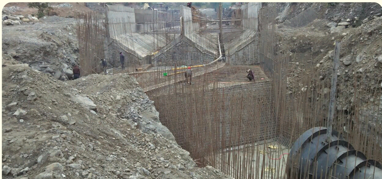
अपर नौगड गाढ जलविद्युत आयोजनाको निर्माणाधीन इन्टेक
