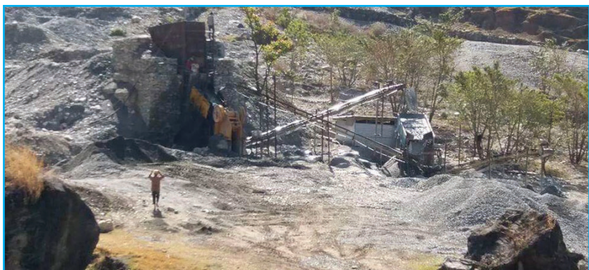
अपर नौगड गाढ साना जलविद्युत आयोजनामा जडित क्रसर प्लान्ट
