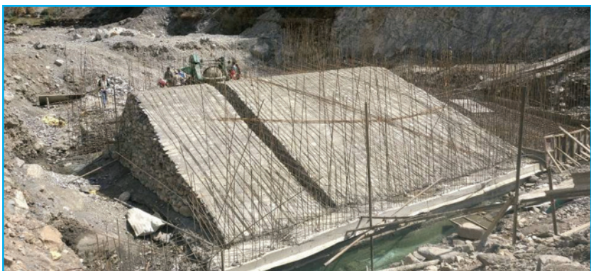
अपर नौगड गाढ साना जलविद्युत आयोजनाको निर्माणाधीन बाँधस्थल
