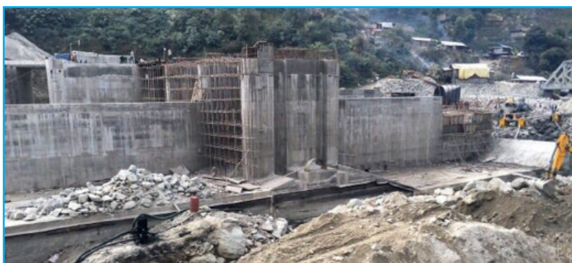
काबेली बी-९ जलविद्युत आयोजनाको निर्माणाधीन इन्टेक
