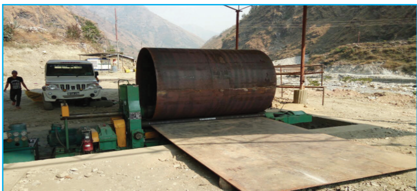
अपर नौगड गाढ साना जलविद्युत आयोजनामा पेनस्टक पाइप निर्माण गरिदै
